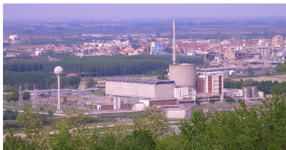
Centrale di Trino
