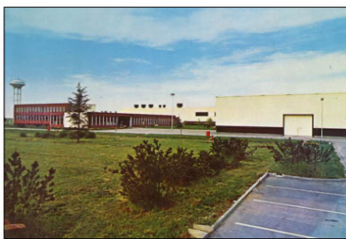
Impianto di Bosco Marengo
